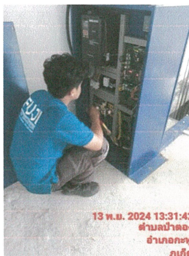
รูปภาพที่ 2.49 การตรวจสอบดูแลการทำงานของลิฟต์
