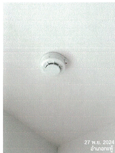
รูปภาพที่ 2.30 เครื่องตรวจจับควัน
