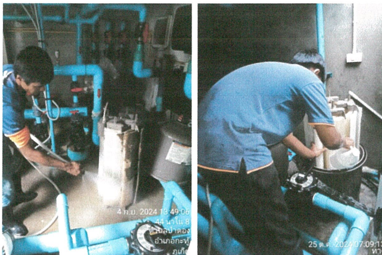
รูปภาพที่ 2.38 การล้างทำความสะอาดเครื่องกรองน้ำ (สระ)
