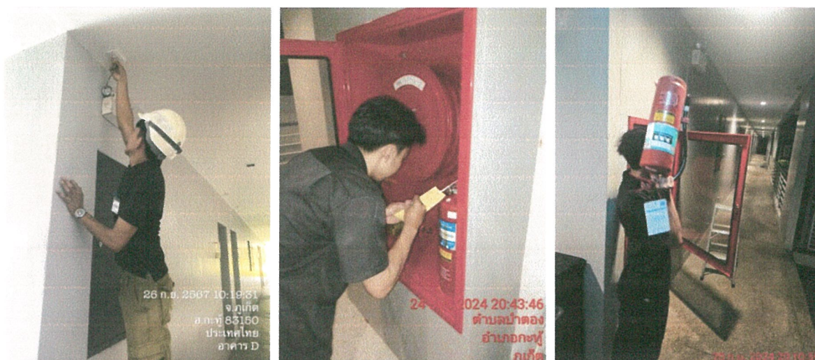
รูปภาพที่ 2.53 การตรวจสอบอุปกรณ์ป้องกันและแจ้งเตือนอัคคีภัย
