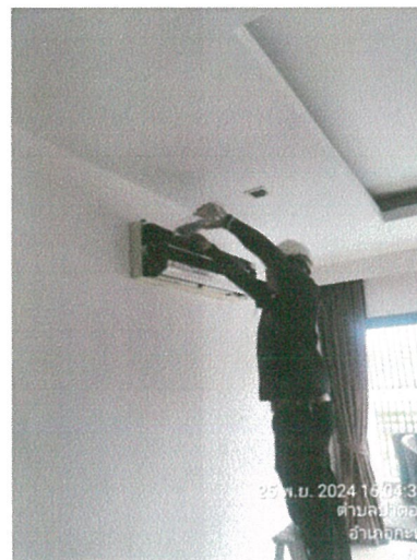
รูปภาพที่ 2.5 การล้างทำความสะอาดเครื่องปรับอากาศ
