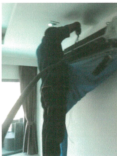
รูปภาพที่ 2.5 การล้างทำความสะอาดเครื่องปรับอากาศ
