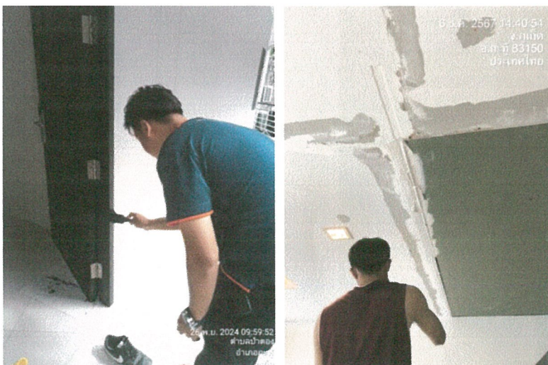
รูปภาพที่ 2.40 การตรวจสอบและอุดรอยรั่วตามผนัง ฝ้าเพดาน ประตู
